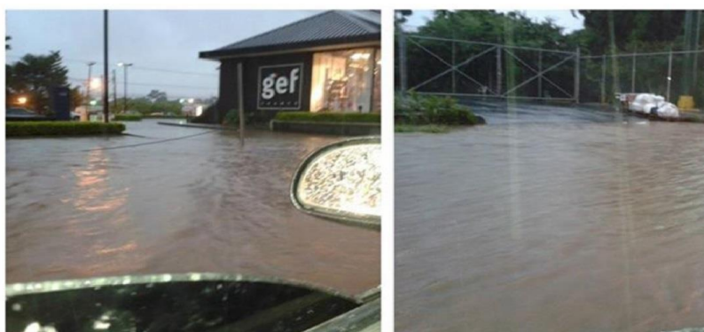
Fig.39 Desbordamiento del río María Aguilar desbordado en Curridabat durante el 28 de septiembre de 2014. Fuente: Twitter y Facebook del IMN.
