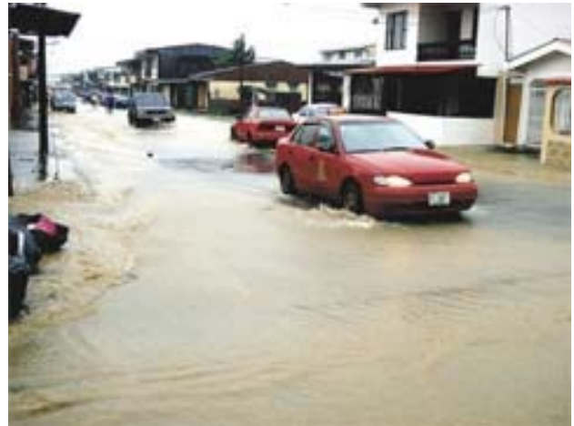
Fig 16. En Limón el alcantarillado colapsó. Domingo 19 julio. Diario Extra.
