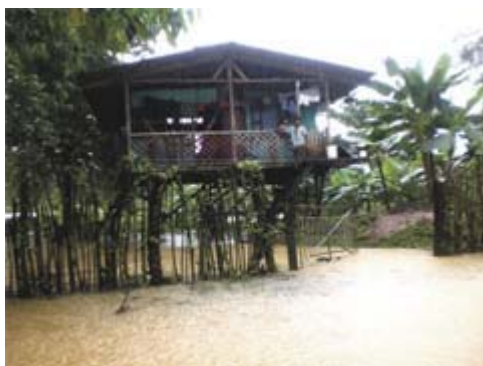
Fig. 15 Vivienda en Matina afectada por las inundaciones. Fuente: Diario Extra.
